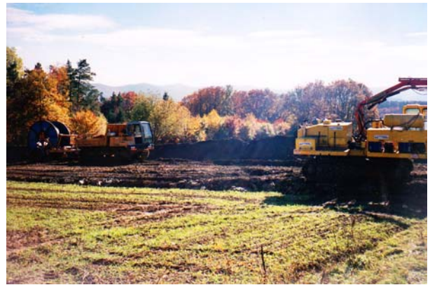
Bauarbeiten zur Herstellung der neuen Erdgas- Fernleitung. Grundstück Winkler
