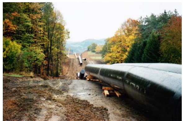
Grundstück der Familie Winkler – Aufnahme wie die beiden nachfolgenden vom 20.10.2007
