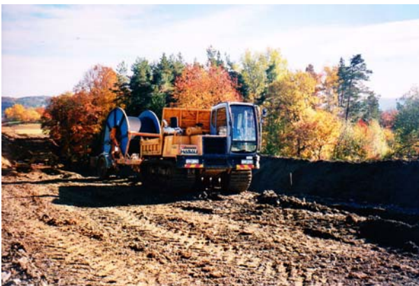
Baustellenbetrieb zur Kapazitätssteigerung der OMV durch Errichtung einer neuen Leitung
