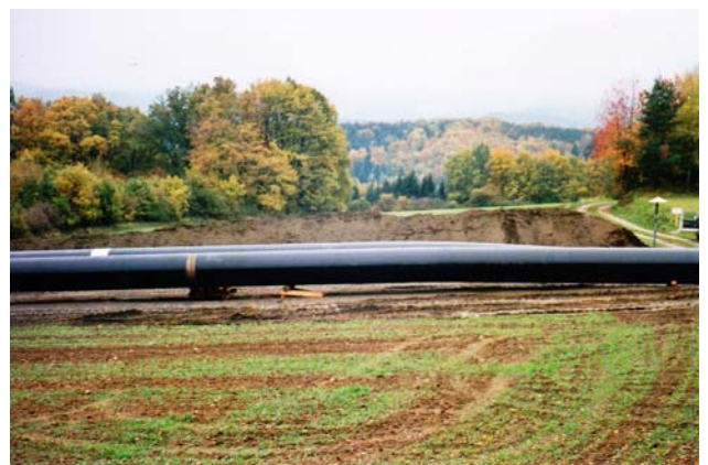
Baustelle zur Grabung der Künette – im Wald wurde eine 8 Meter breite Schneise geschlagen
