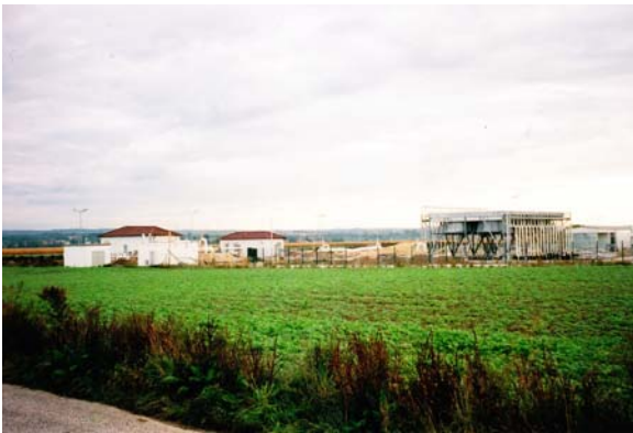
Ausgang der „Molchstation“ (Verdichterstation) in Kirchberg am Wagram
