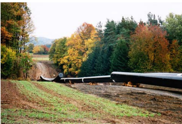
Verlegung des neuen Leitungsstranges („Loop“) der Fernleitung - Grundstücksansicht
